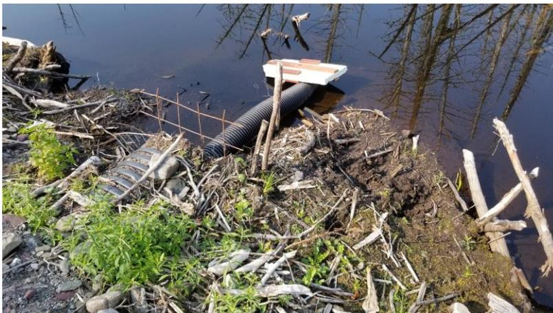
La principale problématique du castor est qu'il inonde par son barrage les terrains et routes adjacentes. Pour éviter ce problème, un système de contrôle du niveau de l'eau a été installé afin de faire une gestion écosystémique du castor. (Photo à gauche)
